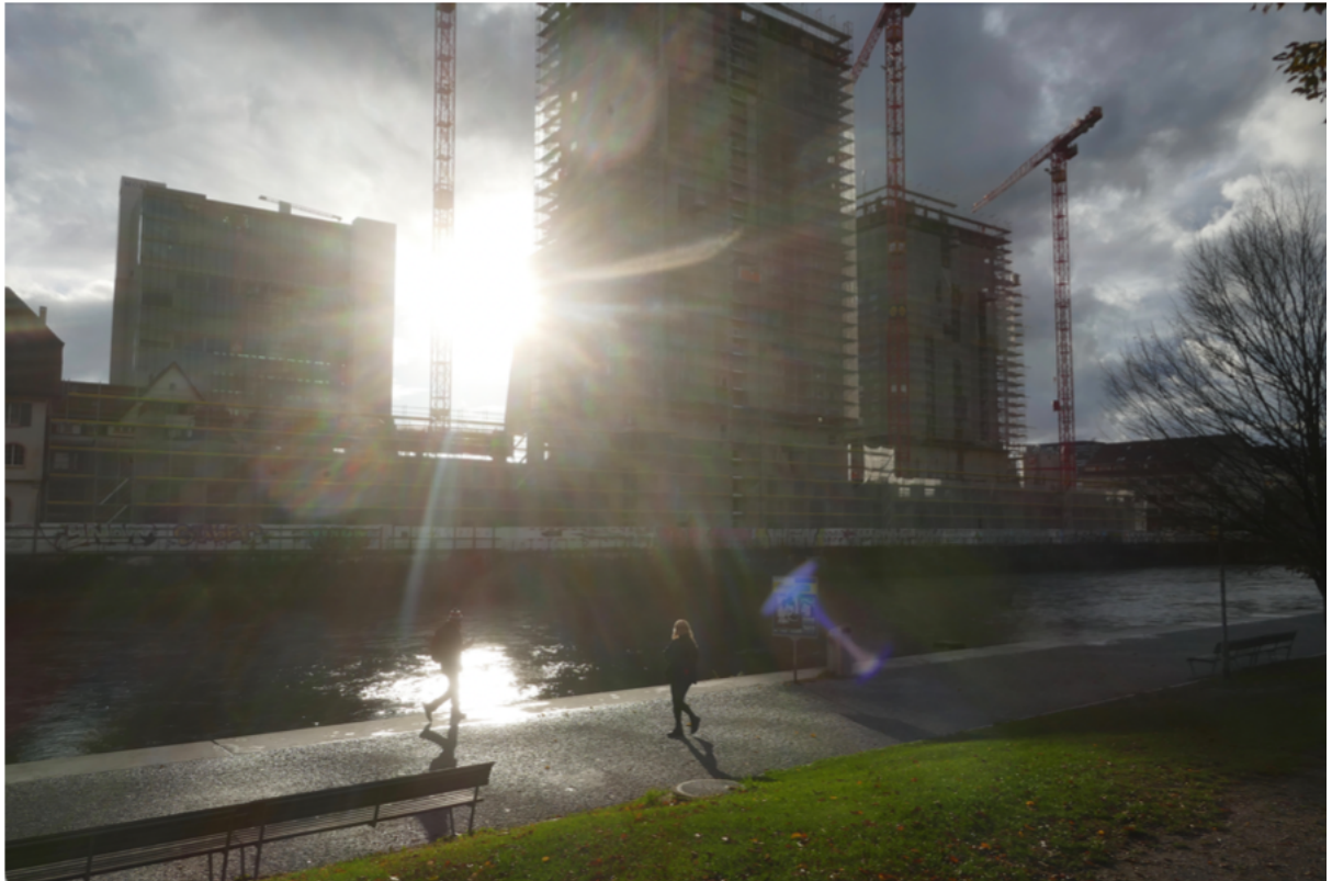
Überbauung Tramdepot Hard beim Escher-Wyss-Platz, 2024
